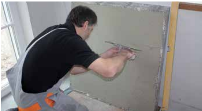
Fig. 11 – Bak smøring av flisa forhindrer luftblømmer og optimaliserer vedheften.
