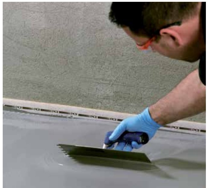
Fig. 4 – Med den lettflytende avrettingsmassen PCI USP 32 S kan ujevne gulv avrettes på en rask og enkel måte.
