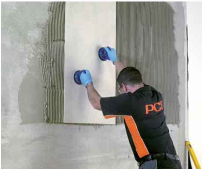
Fig. 2 – Fliser i stort format er ofte skikkelige „tungvektene“... Dette er imidlertid ikke noe problem med det sigefrie, lettflytende flislimet PCI FT® Flex!
