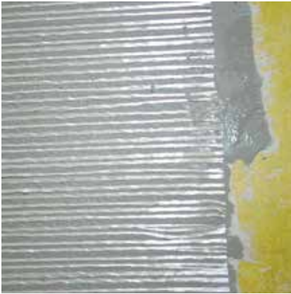
PCI Armeringsmatte GFS er lagt ned og beskyttelsesfolien er fjernet.
