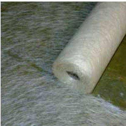
PCI Armeringsmatte GFM rulles ut på det primede underlaget.
