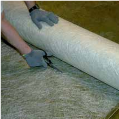
Tilskjæring av PCI Armeringsmatte GFM med saks.
