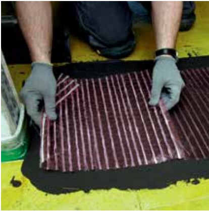
PCI Armeringsmatte GFS legges i den ferske PCI Repafix eller PCI Periplan Extra.
