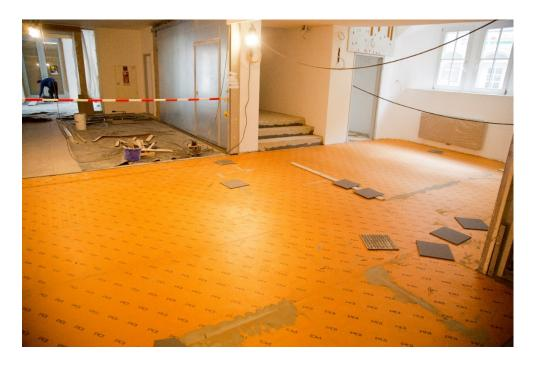
Für die Entkopplung des Untergrundes sorgt in einigen Teilbereichen des Foyers die Abdichtungs- und Entkopplungsbahn PCI Pecilastic U.
