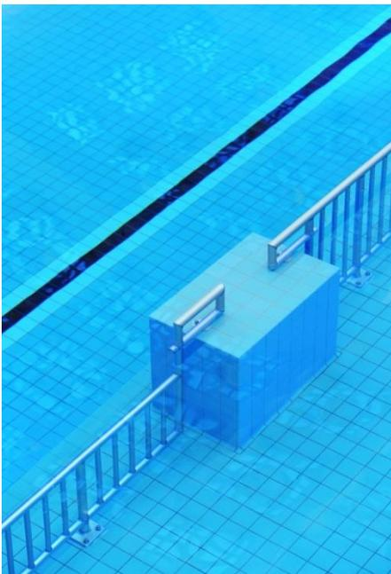
Chemikalienbeständig und wasser- und durchlässig können die Fliesen mit PCI Durapox NT plus verlegt und verfugt werden. Der Mörtel härtet rissefrei aus und bindet schwindfrei ab – für Fugenbreiten von 2 bis 20 mm.
