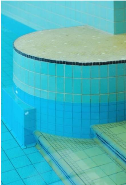
Die Keramikbeläge im Schwimmbecken wurden mit dem 2-komponentigen Reaktionsharz-Fugen- und Verlegemörtel auf einer Fläche von rund 700 m<sup>2</sup> verarbeitet.
