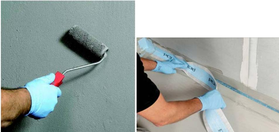
Die schnell abbindende Sicherheits-Dichtschlämme PCI Seccoral 2K Rapid sorgt für eine zuverlässige Abdichtung zwischen Estrich und Bitu Terrazzo® - PCI Pecitape mit den passenden Systemkomponenten bei Rohrdurchgängen, Bodenabläufen, Eckfugen sowie Boden-Wand-Anschlüssen. Bildnachweis: PCI Augsburg GmbH
