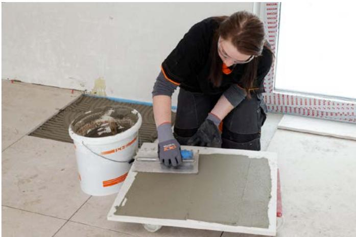
Hierzu wurde PCI Carrament Grau sowohl auf den Untergrund als auch auf die Rückseite der Naturwerksteinplatten aufgebracht.
