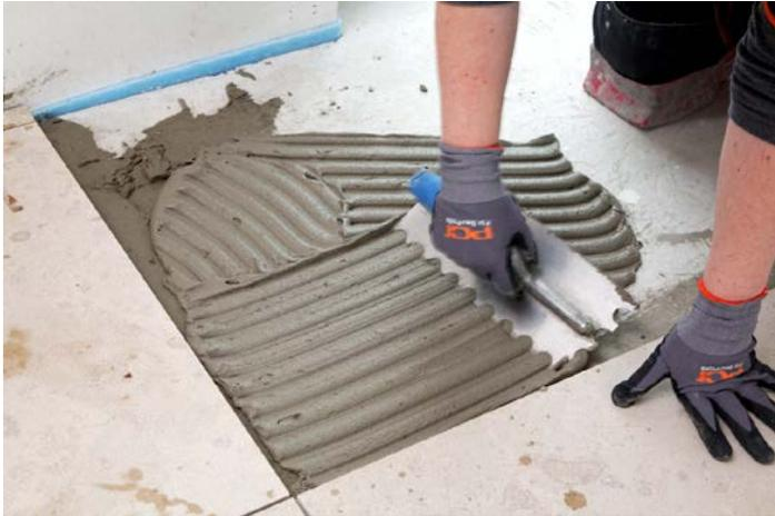
Für die möglichst hohlraumfreie Verlegung der Platten wendete die Fliesenlegerin das Buttering-Floating-Verfahren an.
