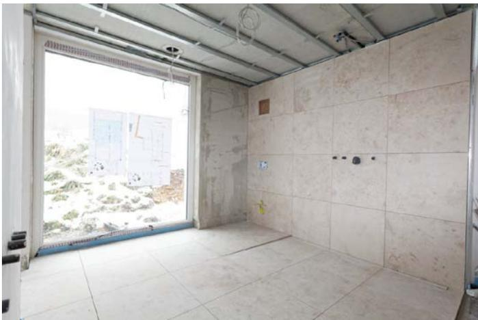
Nach der Grundierung mit PCI Gisogrund und der Abdichtung mit PCI Seccoral 2K Rapid kamen auch im Badezimmer die Naturwerksteinplatten zur Verlegung.
