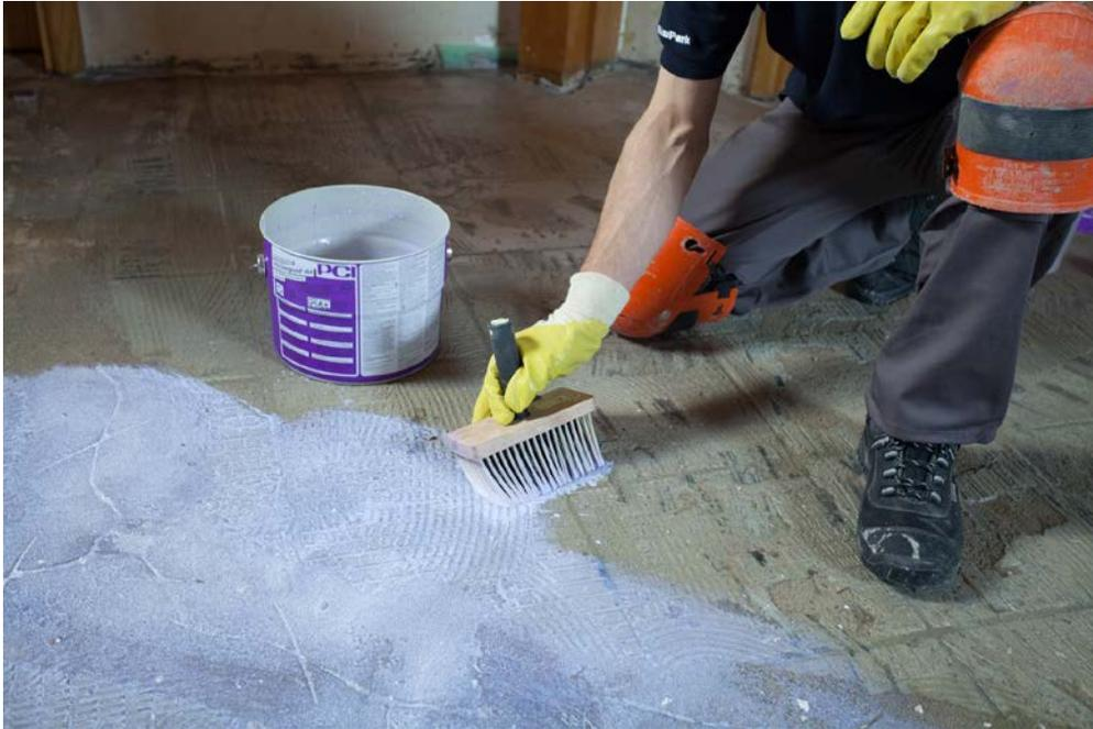
Mit PCI Gisogrund 404 wurde die gesamte Fläche für die Verlegung der großformatigen Fliesen vorbereitet.
