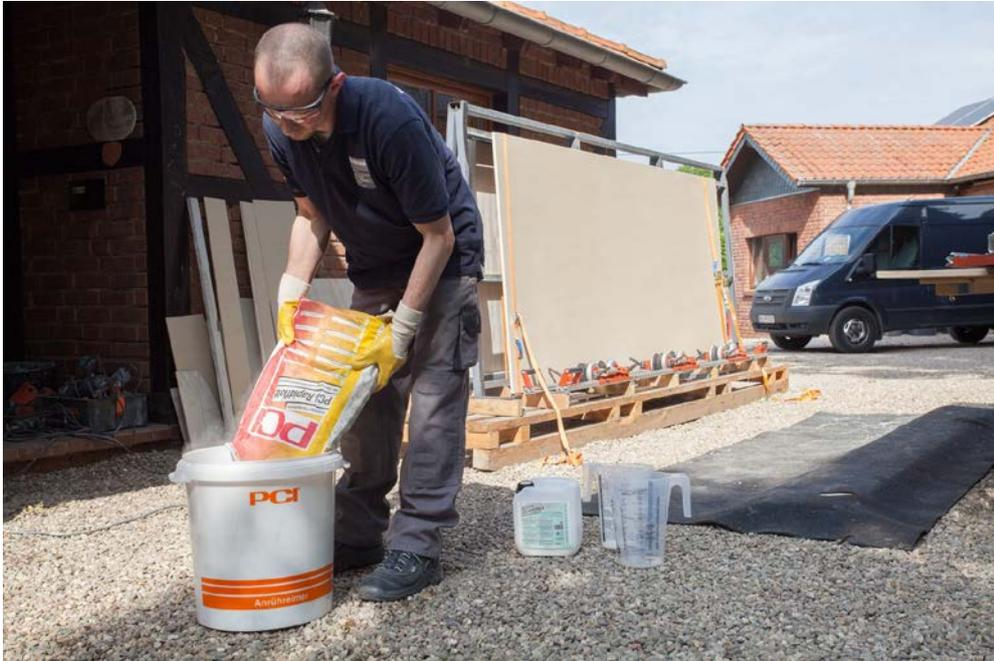
Mit dem flexibilisierenden Zusatz PCI Lastoflex vergütete der Fliesenlegermeister den Fließbettmörtel PCI Rapidflott.
