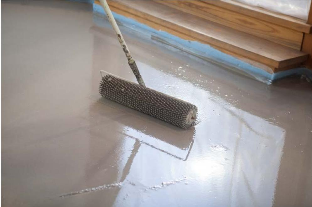
Mit einer Kufenrakel wird PCI Periplan Extra verteilt und anschließend zur Entlüftung und Feinnivellierung mit einer Stachelwalze bearbeitet.
