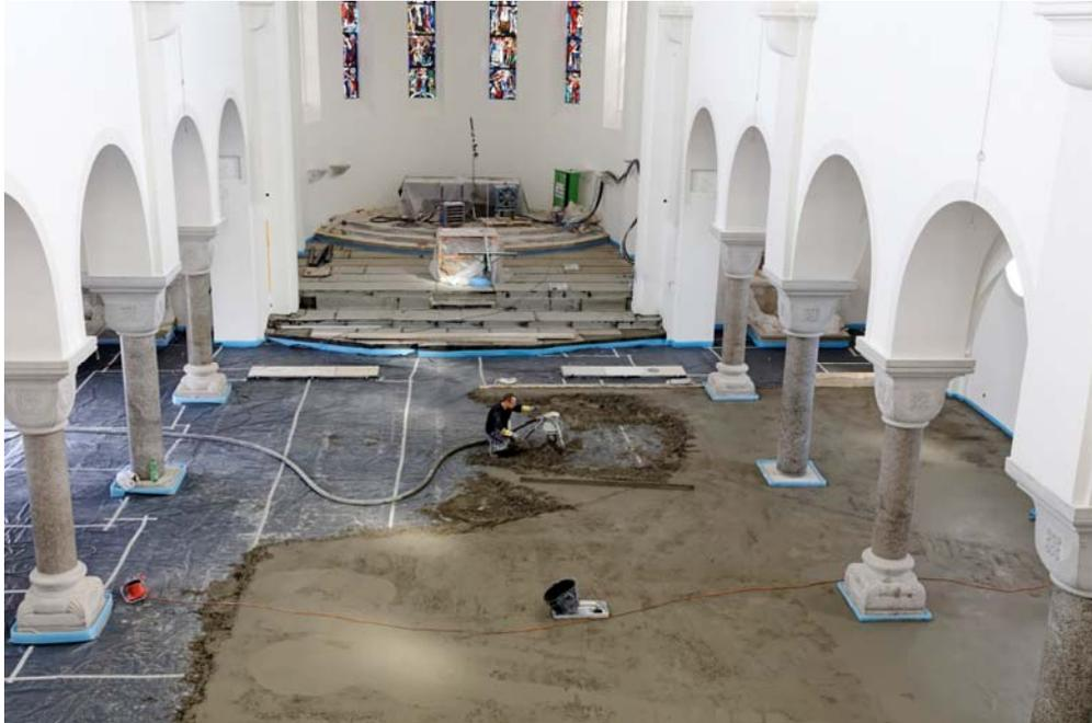
Bild 5: Dank der sehr spannungs- und verformungsarmen Eigenschaften von PCI Novoment Z3 ließen sich große Estrichflächen herstellen.
