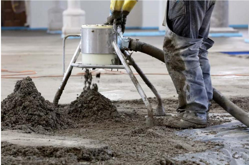
Bild 2: Mittels Pumpenförderung transportierten die Handwerker den frischen Estrich auf den Kirchenboden.
