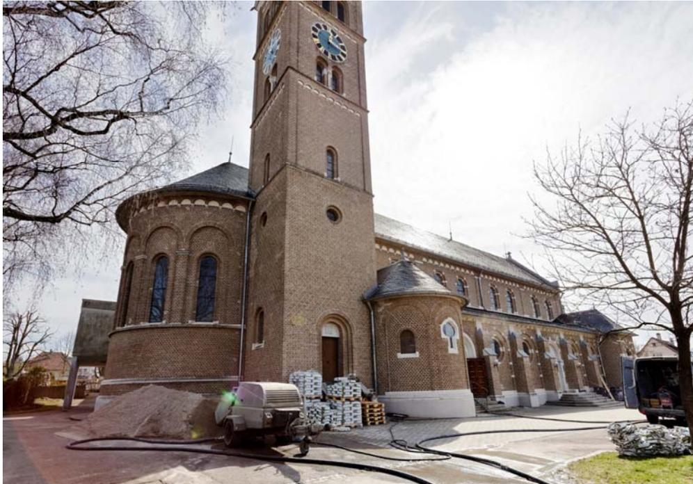
Bild 1: Die katholische Kirche St. Margaretha in Salach im Landkreis Göppingen: Auf der gesamten Bodenfläche von 650 m<sup>2</sup> wurde ein neuer Estrich mit PCI Novoment Z3 installiert.
