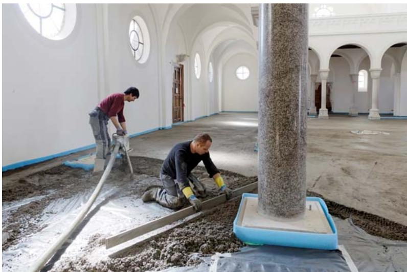
Bild 3 und 4: Die lange Verarbeitungszeit von rund einer Stunde gab den Handwerkern genügend Zeit für den Einbau der großen Estrichflächen mit PCI Novoment Z3.
