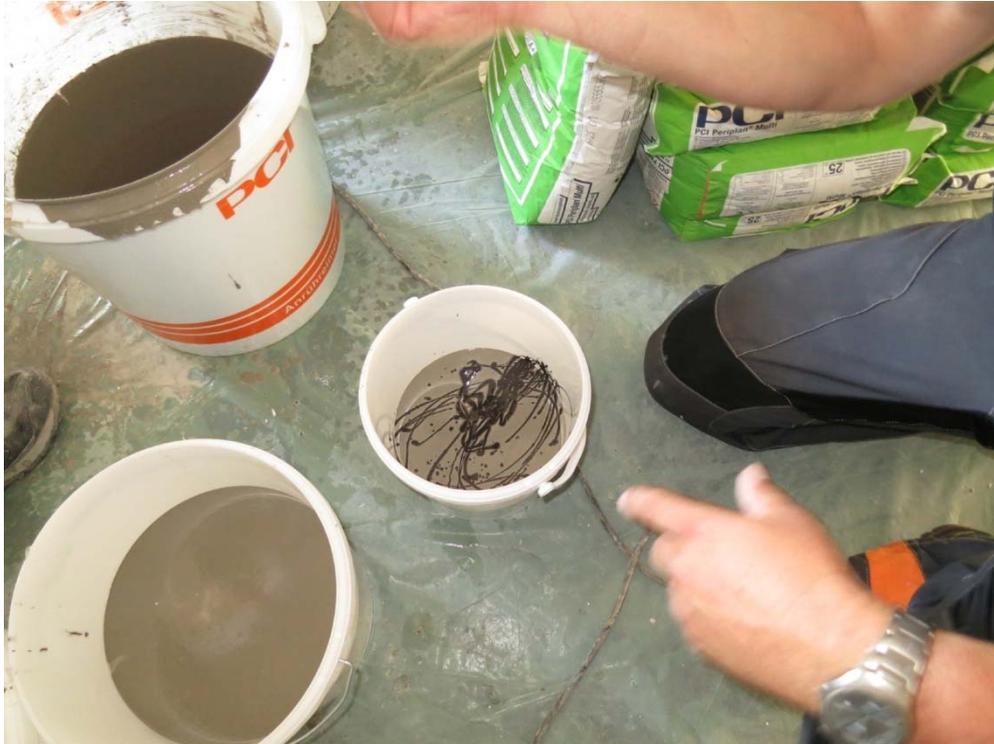
Bild 5: Die leicht verlaufende Zement-Bodenspachtelmasse PCI Periplan Multi lässt sich einfach anmischen, mit dem MIXOL Abtönkonzentrat Oxyd-Type einfärben und komfortabel durch Gießen einbauen.
