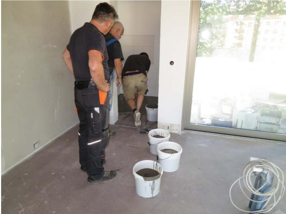
Bild 6: Bauherr und Verarbeiter in Personalunion: Holger Andreas baute den Boden in Eigenregie ein und entschied sich für die selbstverlaufende Bodenspachtelmasse PCI Periplan Multi.
