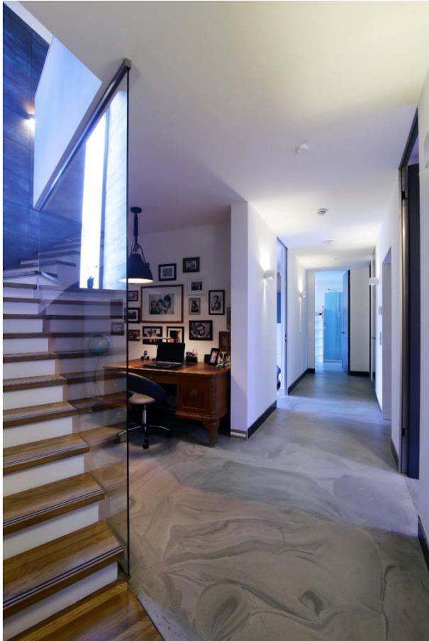
Bild 2: Es entstand ein Bodenbelag mit ansprechenden Farbverläufen, der neben den optischen Anforderungen auch besondere räumliche und thermische erfüllt. Einige Zimmer sind aufgrund großer Fensterflächen stark lichtdurchflutet, daher war ein Bodenbelag gefragt, der thermischer Spannungen abbauen kann und lichtbeständig ist.
