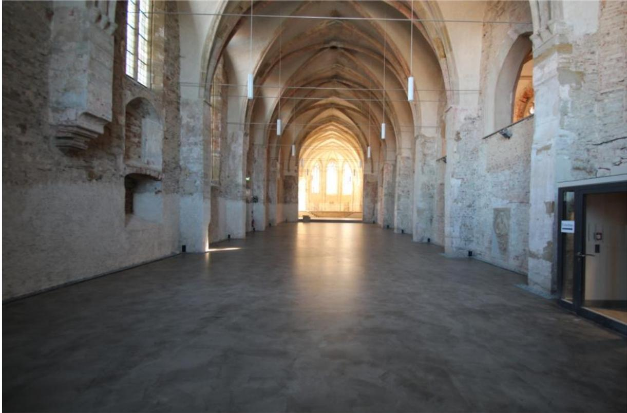
Zum Abschluss der Bodensanierung wurde die Dispersions-Versiegelung PCI Zemtec Top lasierend aufgetragen. So konnte eine aufgelockerte Oberflächenoptik erzielt werden. Darüber hinaus ist der Untergrund in der Franziskanerkirche nun rutschhemmend und verschleißfest – bereit für kommende Veranstaltungen.
