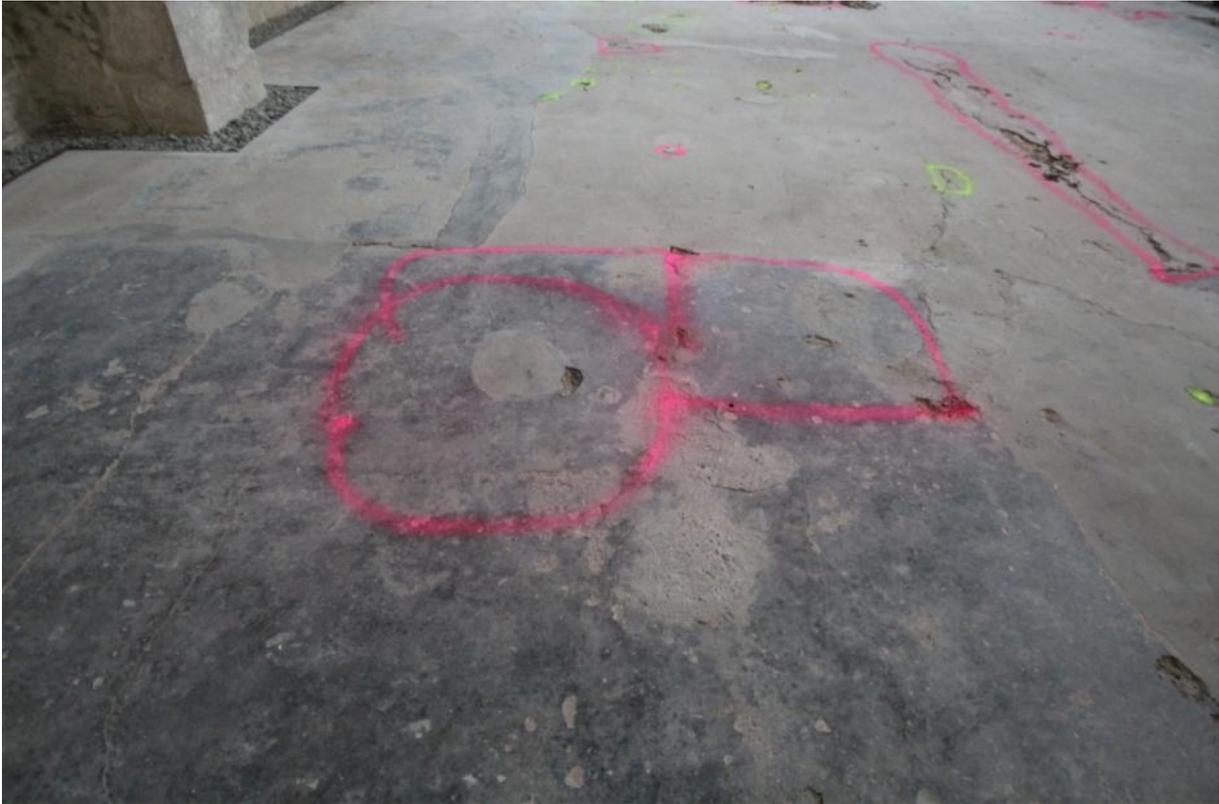
Zur Vorarbeit der Bodensanierung gehörte in der Franziskanerkirche die Markierung von Fehlstellen, flächigen Hohllagen sowie Rissen im Untergrund. Auf diese Weise konnten keine Schäden übersehen werden.
