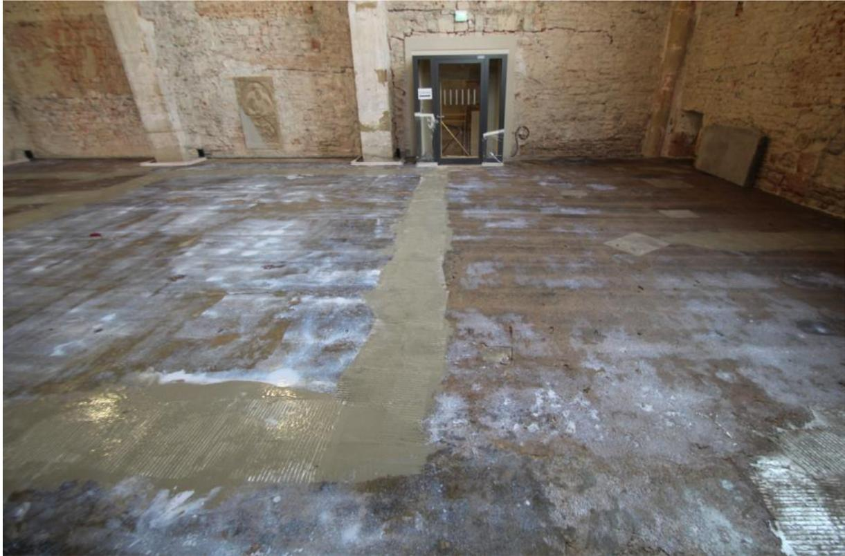
Auf den reprofilierten Boden wurde die Spezial-Haftgrundierung PCI Gisogrund 404 in zwei Lagen aufgetragen. Die violette Kontrollfarbe der Kunstharzdispersion erlaubt exaktes Arbeiten. Auf diese Weise schufen die Bau-Profis einen verbundhafftesten Untergrund für den nachfolgenden Belag.
