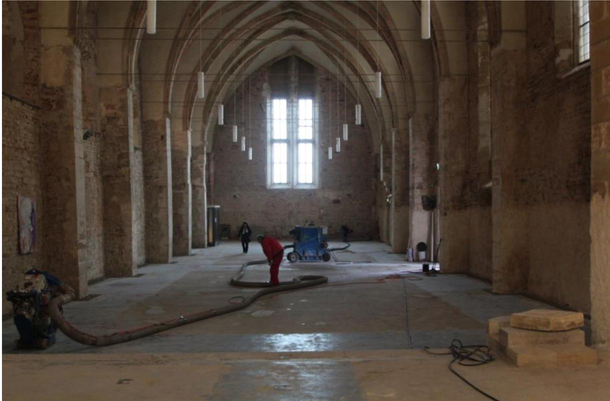
Alle haftungsfeindlichen Schichten sowie Verunreinigungen beseitigten die Verarbeiter mit Hilfe von Stahlkugelstrahlern, bevor sie die Fehlstellen mit einem standfesten Instandsetzungsmörtel reprofilierten.
