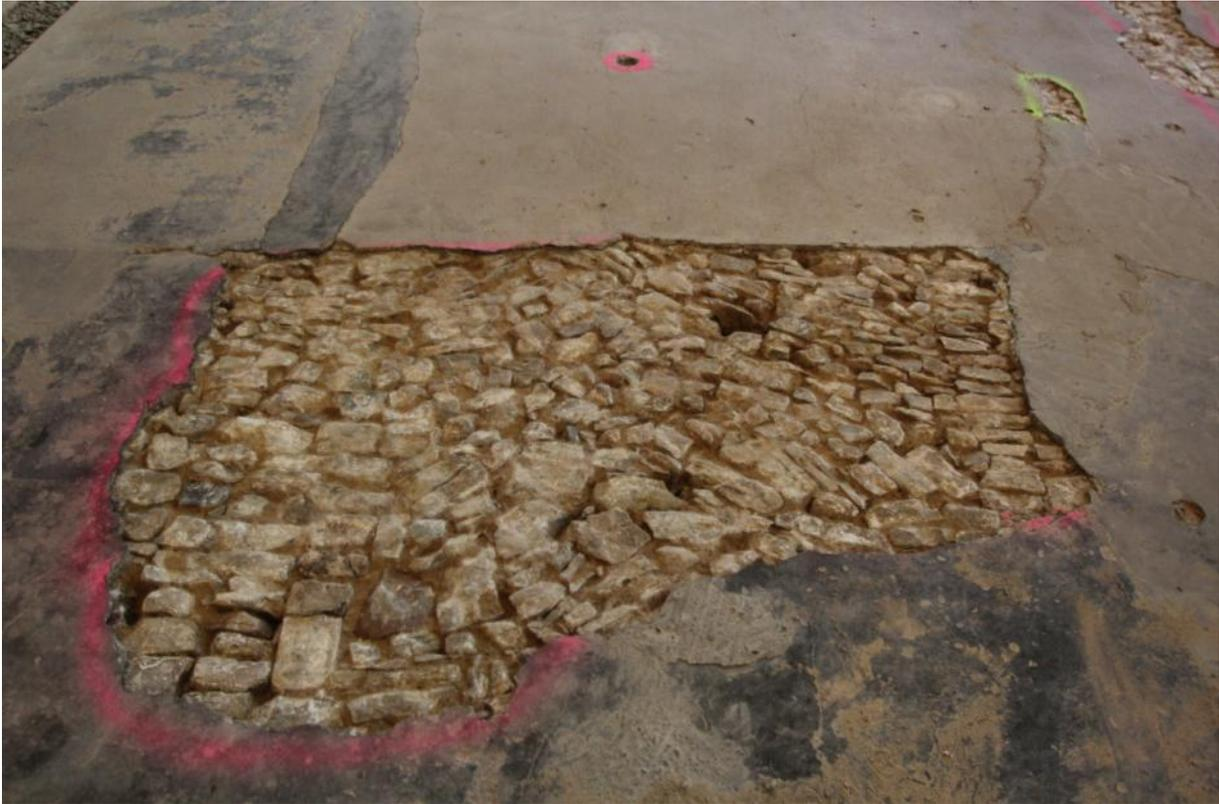
Unter dem bestehenden Estrich unterschiedlicher Güte befindet sich ein historisches Pflaster. Dieses sollte in jedem Fall erhalten bleiben. Nach notwendiger Entfernung von beschädigten Flächen konnten die Bau-Profis den Untergrund reprofilierten.
