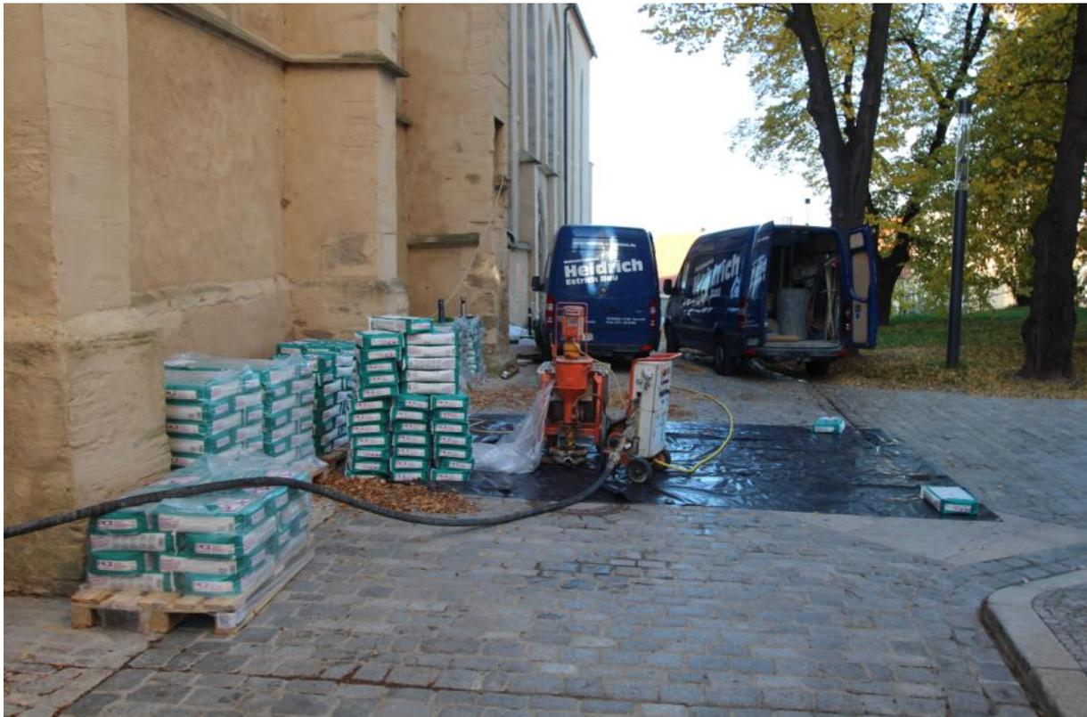
Das Team um Andreas Heidrich verarbeitete insgesamt etwa acht Tonnen des Zement-Bodenausgleichs PCI Zemttec 1K. Um eine hohe Arbeitsleistung zu gewährleisten, pumpten die Verarbeiter das Produkt ins Innere der Kirche.
