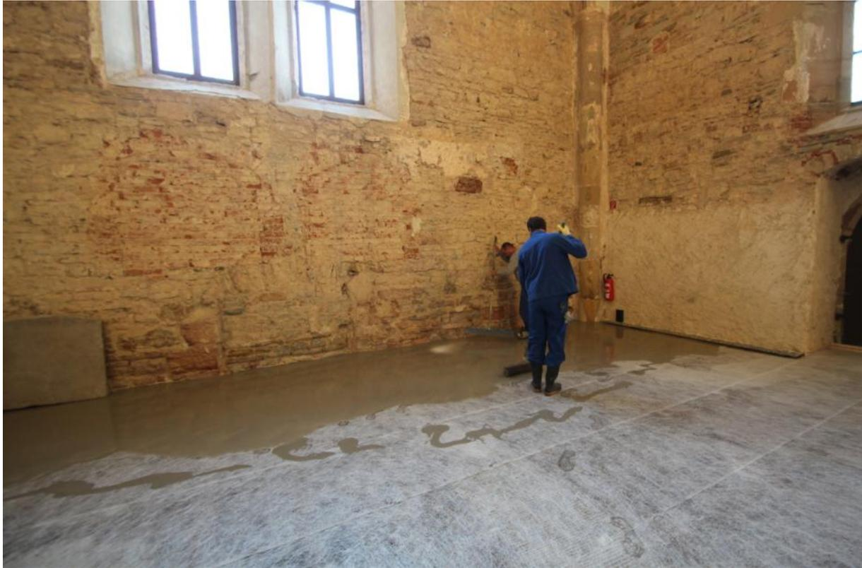
Die Bodenausgleichsmasse entlüfteten und egalisierten die Bau-Profis mit Hilfe von Stachelwalzen. Da das Produkt leicht verläuft, lässt es sich bei geringem Arbeitsaufwand einfach verarbeiten.
