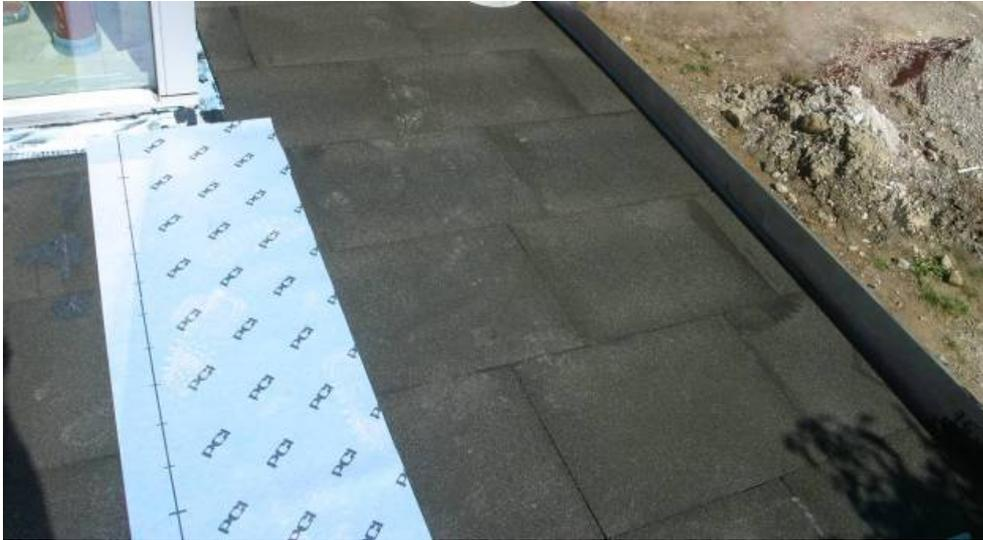
Terrasse und Flachdach in einem: Unter der Terrasse der Murnauer Immobilie befindet sich eine Garage. Deshalb dämmen mineralische Glasschaumplatten, die mit dem Bitumen-Dämmplattenkleber PCI Pecimor DK verklebt wurden, den Raum vor Kälteeinwirkung und schützen den Oberbelag vor Wasserdampf.
