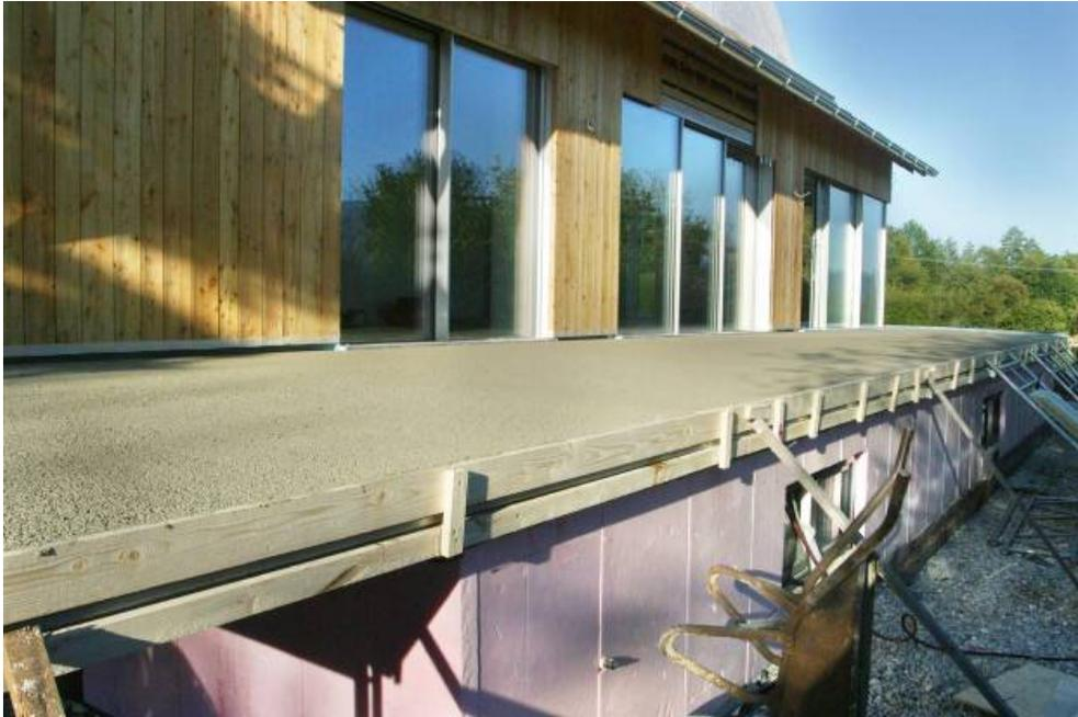
Nun ist der Untergrund bereit für die Plattenverlegung: Ein Drainagesystem sorgt für eine ideale Entwässerung, so dass Niederschlag und Witterung keine Gefahr für das folgende Feinsteinzeug darstellen. Unter der Drainage wiederum sorgt ein System aus Bitumenschicht, Dämmplatten und Sicherheits-Dichtschlämme für Trockenheit in der unter der Terrasse befindlichen Garage.
