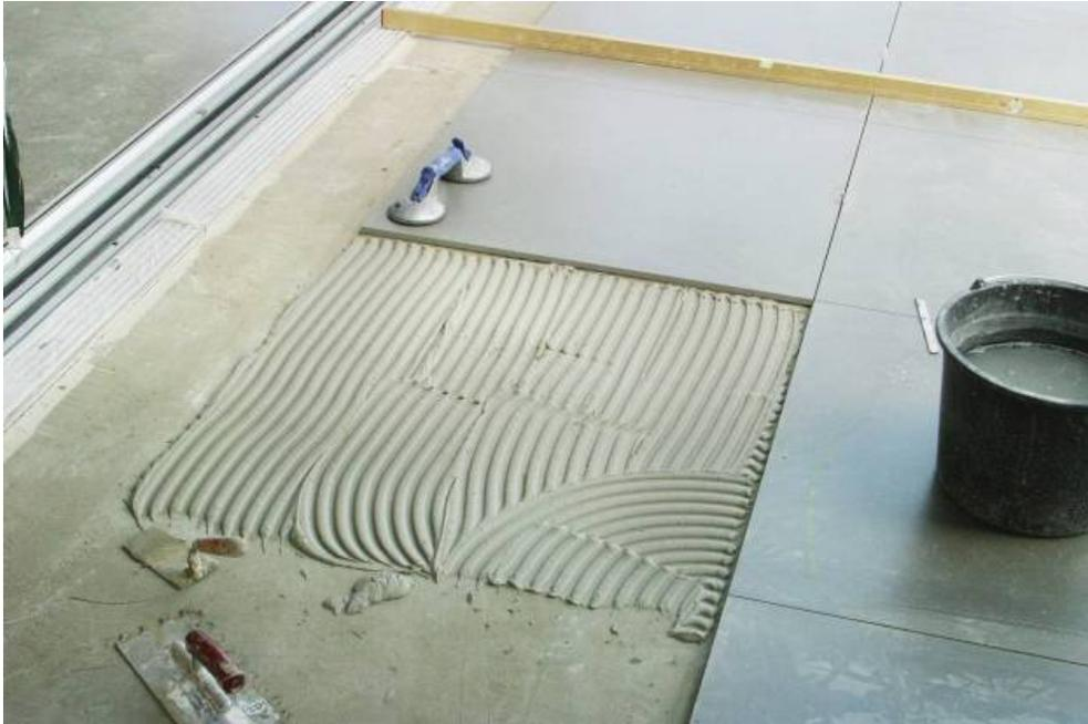
Mit dem verformungsfähigen Fließbettmörtel PCI Rapidflott in Verbindung mit dem flexibilisierendem Zusatz PCI Lastoflex verklebten die Verarbeiter die neuen 90 mal 90 cm großen Feinsteinzeugplatten sicher auf der Murnauer Terrasse. Die Produktkombination ist wasserfest, frost- und witterungsbeständig und daher ideal für die Verlegung von Keramik im Außenbereich.
