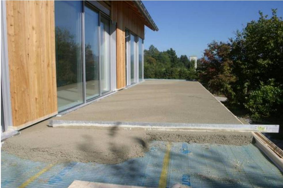
Die Lage aus Drainagematten und dem Drainmörtel PCI Pavifix DM wirkt ähnlich wie Stelzlager. Das System aus Matte und Mörtel sorgt für eine schnelle und verzögerungsfreie Entwässerung.
