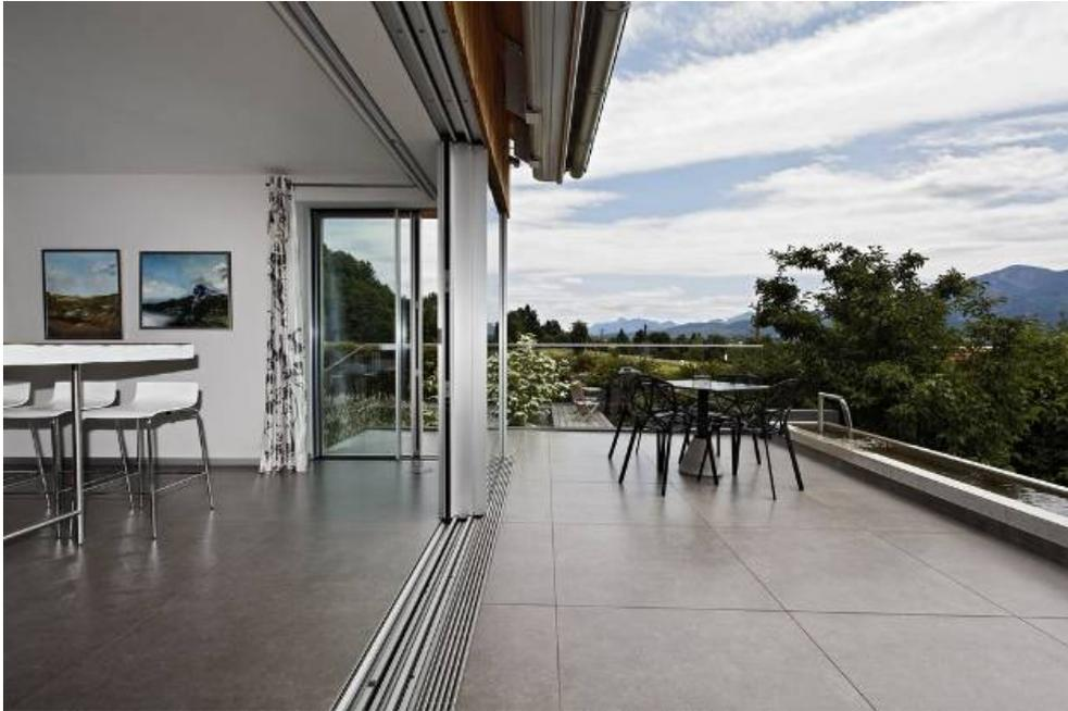
In der Hausfassade sind zu einem großen Teil bodenbündige Fenster eingebaut. Hier wurden am angrenzenden Bereich die Bodenplatten gerade verlegt. Aufgrund dessen erstellten die Verarbeiter eine Konstruktion, die einerseits das Gesamtbild nicht stört und andererseits funktionell Wasser abführt.
