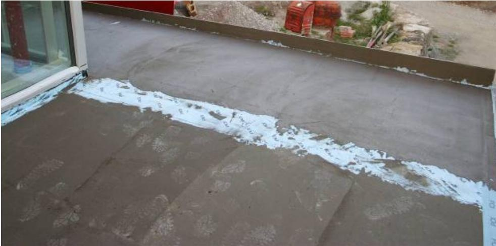
Mit der Sicherheits-Dichtschlämme PCI Seccoral 2K Rapid dichteten die Verarbeiter die Oberseite der Dämmplatten ab. Durch die Sicherheits-Dichtschlämme kann kein Wasser in den Raum unter der Terrasse gelangen – der ist sicher.
