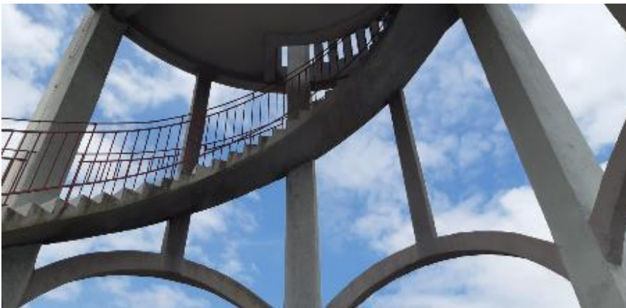
Der Maggi-Wasserturm in Singen, eine Meisterleistung an Schalungs- und Betoniertechnik, wurde auf dem obersten Arkadengang mit PCI-Produkten saniert und ist nun gut geschützt gegen alle Witterungseinflüsse. Link zum hochauflösenden Photo
