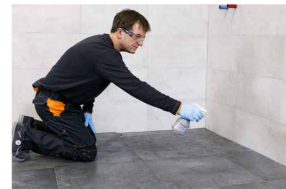
Før den endelige vaskingen sprayeres det PCI Durapox Finish (væske) på overflaten i ca. 60 minutter. Alternativt kan også PCI Durapox Finish (konsentrat) tilsettes direkte i vaskevannet.
