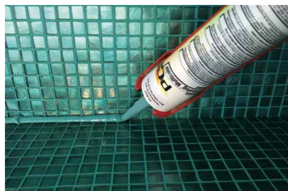
Lett lukking av hjørne-, bevegelses- og tilslutningsfuger i sanitære områder, i svømmehaller og på balkonger og terrasser.
